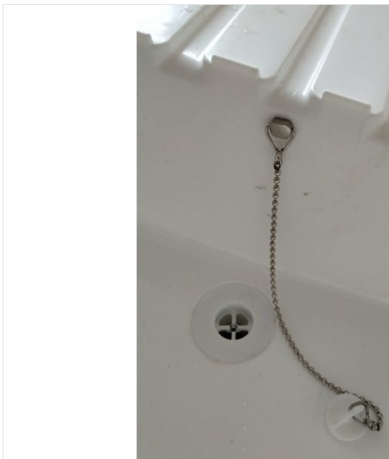
Étape 8 - Installer écrou de chaînette de lavabo (facultatif)
