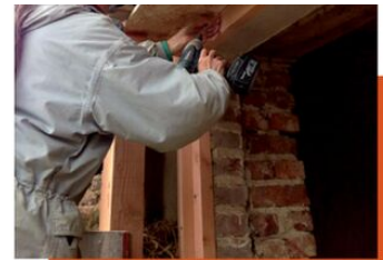
Montage du linteau
